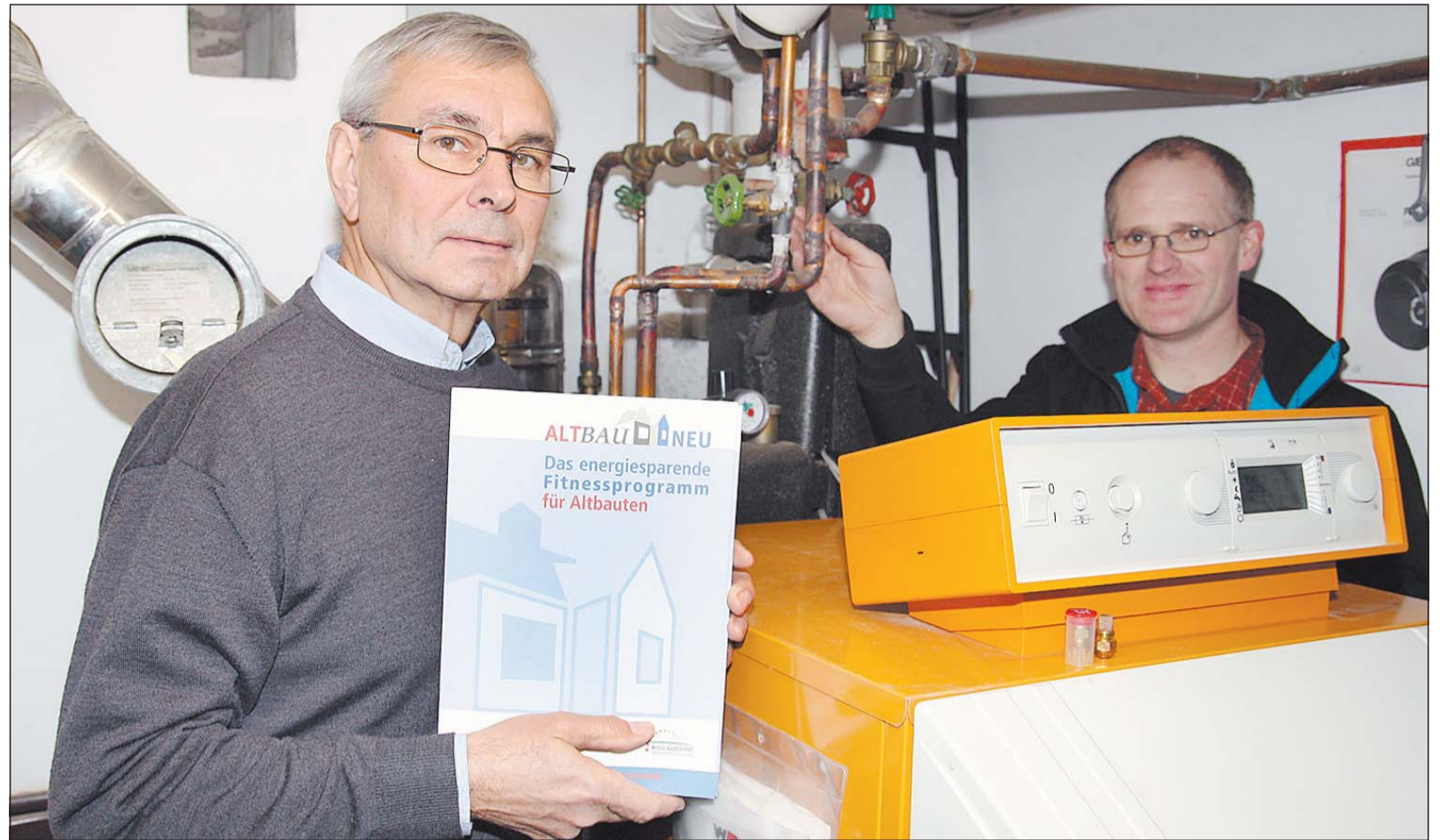
Tipps und Tricks zum Energiesparen liefert der Experte bei der Beratung frei Haus: Im Keller der Doppelhaushälfte von Familie Nikelski begutachtet
